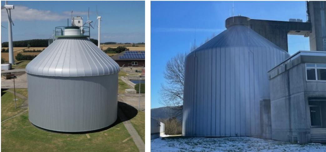
Außenverkleidung Faulbehälter: Kombination aus Sinuswelle und Segmentbahnen (links), vollflächige Segmentbahnen (rechts)
