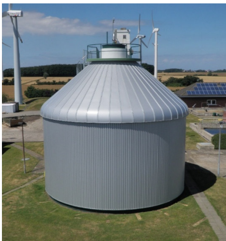
Abbildung 2: Außenverkleidung Faulbehälter: Kombination aus Sinuswelle und Segmentbahnen (links), vollflächige Segmentbahnen (rechts)
