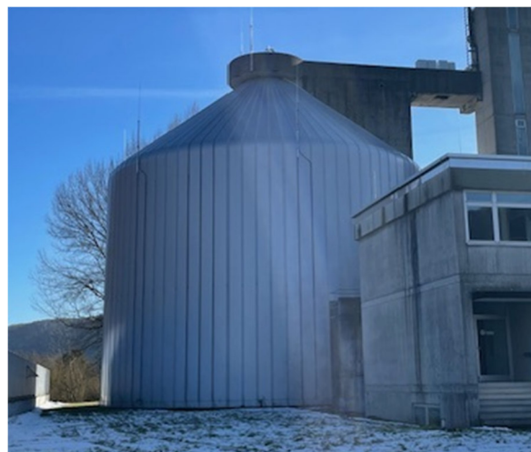
Abbildung 2: Außenverkleidung Faulbehälter: Kombination aus Sinuswelle und Segmentbahnen (links), vollflächige Segmentbahnen (rechts)
