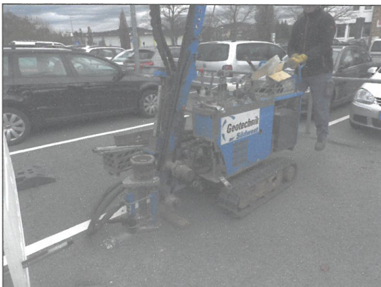
Bild 6: Sondierbohrungen im Parkplatz P1
