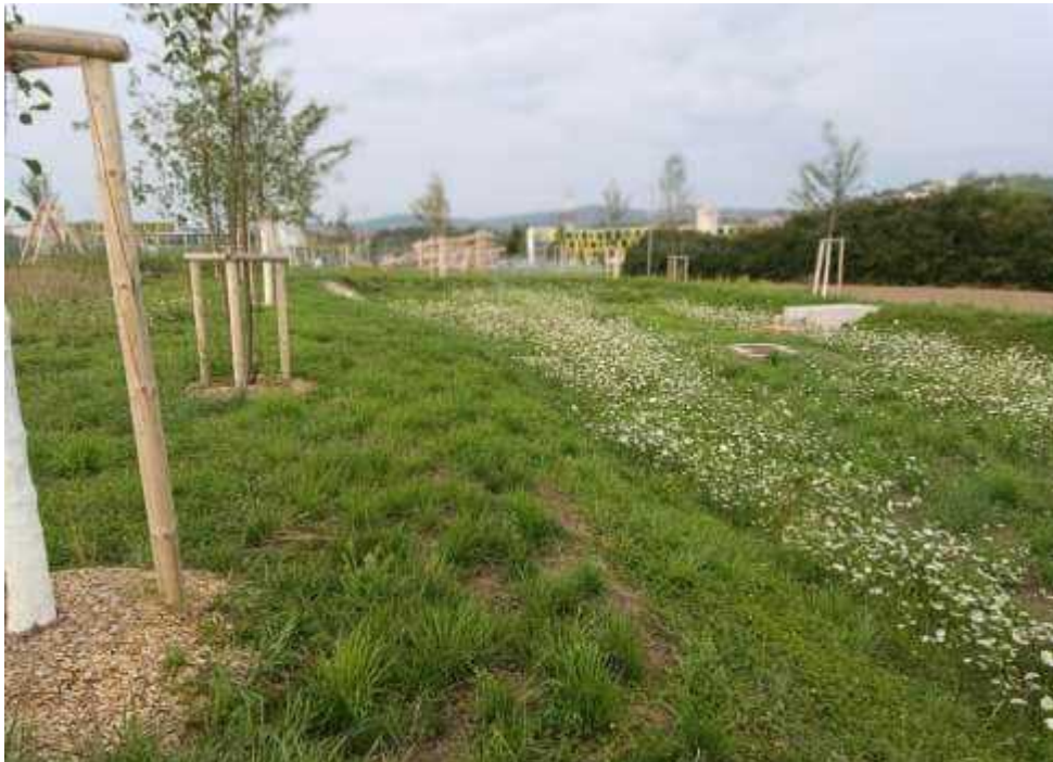
Bildnachweis: Retentionsmulde mit standortgerechten Gehölzen und artenreicher Ansaatmischung (Menges 17.08.2023)
