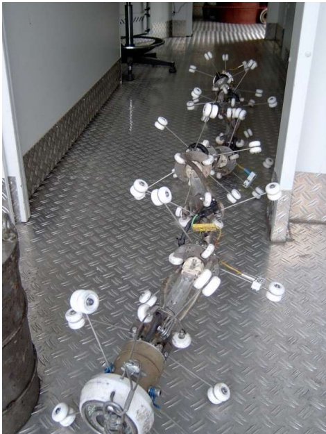
UV-Lichterkette zur Aushärtung des Schlauchliners
