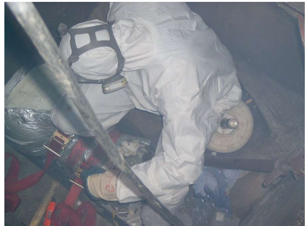
Aufschneiden und Anpassen des Schlauchliners im Schacht
